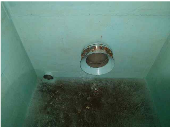
손상내용 2지 유출 배관 현황 손상원인 -
