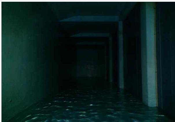
배수지 1지 내부 전경
