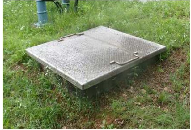
환기구 등의 덮개(장비 반입구) 현황
